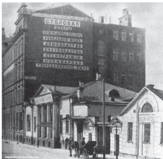
Здание на Никитском бульваре, д. 13. (Фотография 1910–1911 гг.)
